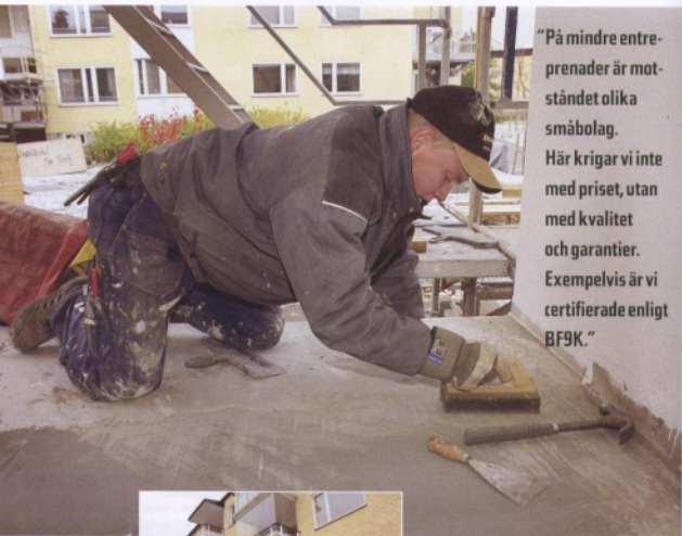
Jonas Gradin gjuter balkong- ördrupning.
